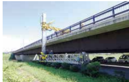
橋梁などの社会インフラを守るため、定期的に点検を行っています（国道4号・白河大橋）
